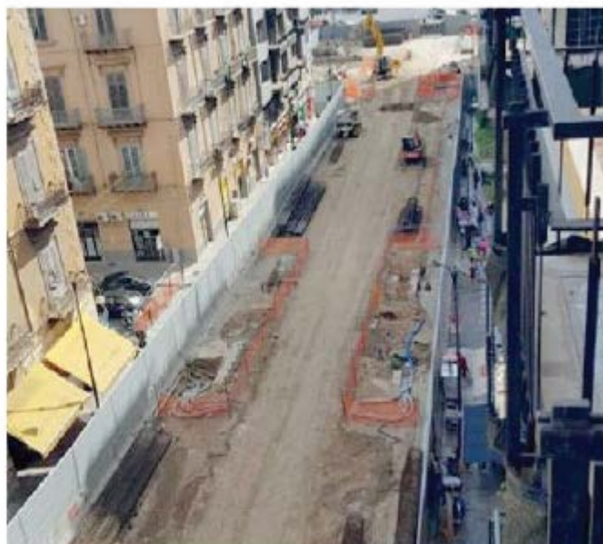
L'OPERA CONSISTE NELLA REALIZZAZIONE DI TRE NUOVE FERME
